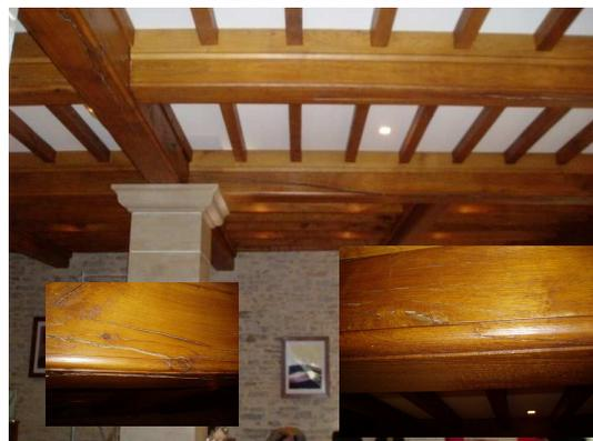
Fissures et délaminations: bois lamellé collé
