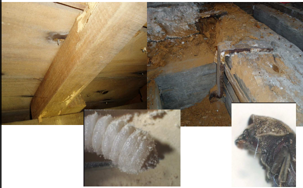
Durabilité insuffisante: dégradations par les insectes
