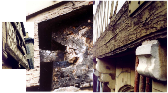
Conséquences dommageables des variations de teneur en eau
