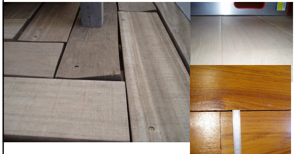
Conséquences dommageables des variations de teneur en eau: Retrait et tuilages irréversibles
